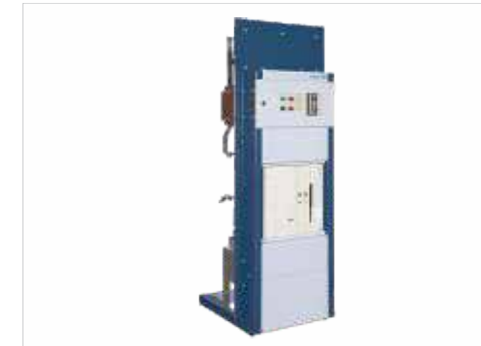
Disjuntor de Média Tensão
