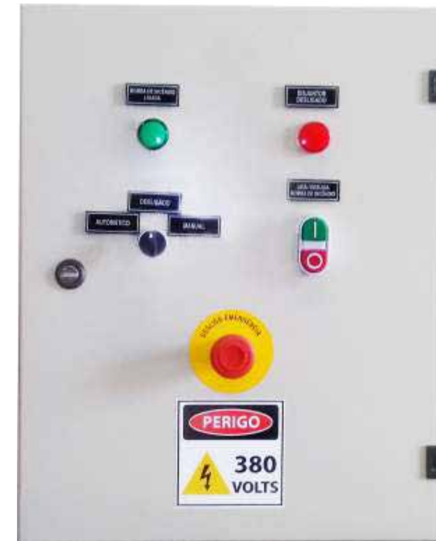
QUADRO DE COMANDO DE BOMBAS DE RECALQUE
